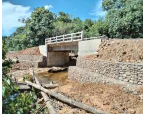
Const. Puente Vehicular Sacacho Sind. Litoral Central 15 de Diciembre (RECURSOS PROPIOS)
