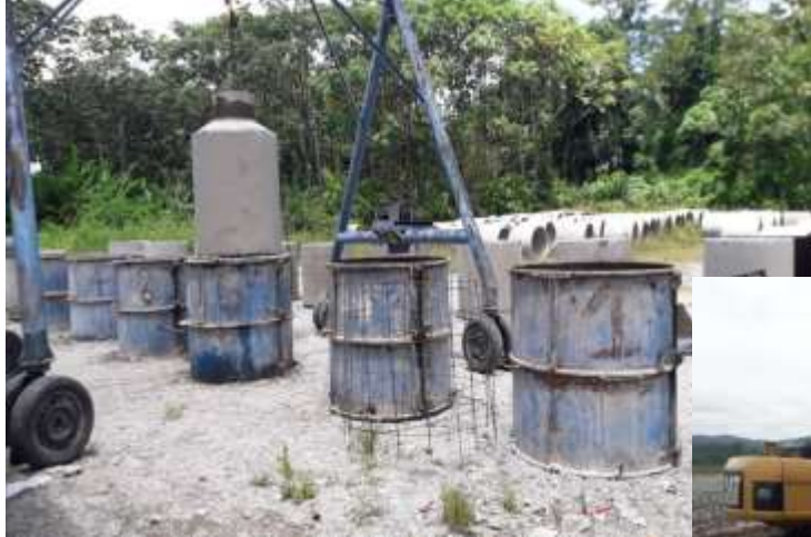
HORMIGONADO DE 250 ANILLAS
