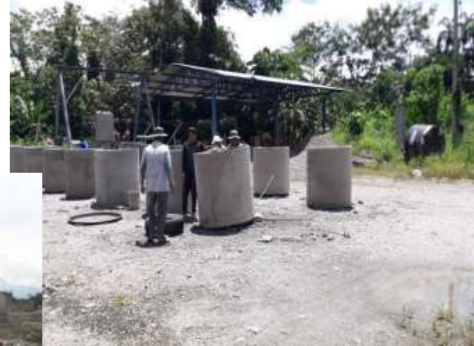
HORMIGONADO DE 250 ANILLAS
