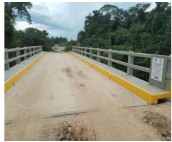
Construcción puente vehicular Mambuelo I Central Nueva Tacopaya D-8 - Municipio de Villa Tunari (CONVENIO FONADIN)
