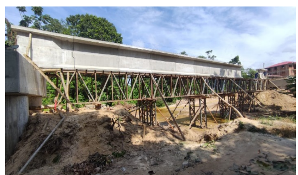
CONST. PUENTE VEHICULAR VILLA URKUPIÑA CENTRAL 10 DE MAYO D8 VILLA TUNARI
